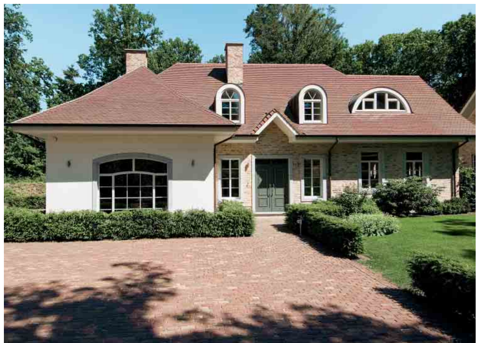
Stilgerecht und liebevoll renoviert – der Charakter bleibt erhalten.
